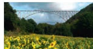
Viaduc du Viaur
